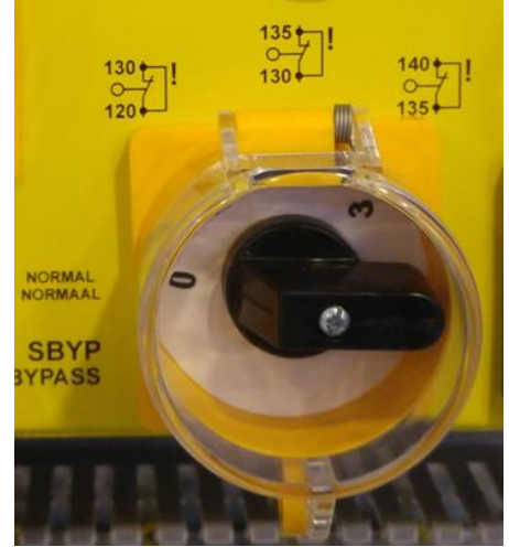
Şekil 21a: By-pass anahtarı
